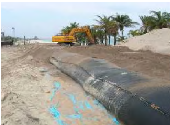
Figura 10. Colocación de tubos geotextiles (geotubos) en el año 2006 frente al Hotel Grand Velas, Riviera Maya. Fuente: López (2014) y Timpson y Stephens (2018).
