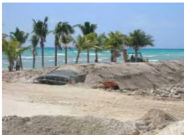
Figura 10. Colocación de tubos geotextiles (geotubos) en el año 2006 frente al Hotel Grand Velas, Riviera Maya. Fuente: López (2014) y Timpson y Stephens (2018).
