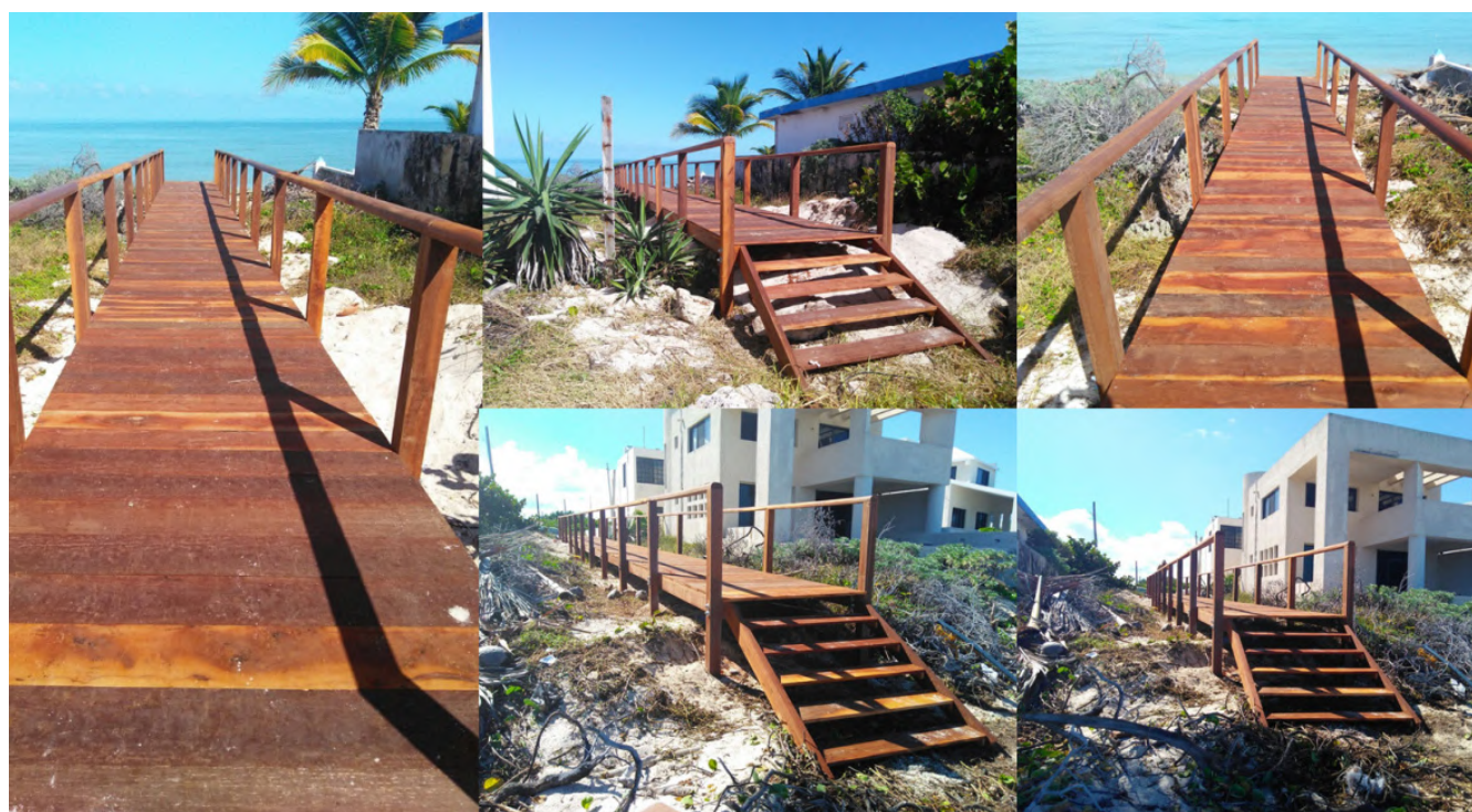
Figura 18. Pasarela de 25 m en proyecto de restauración Telchac-Chixchulub. Protege un área vegetada de 200 m 2 , con una elevación aproximada de 50 cm desde el nivel del suelo. Permite el libre acceso y tránsito peatonal en un área pública con salida a la playa. Fotografías: Gabriela Mendoza.
