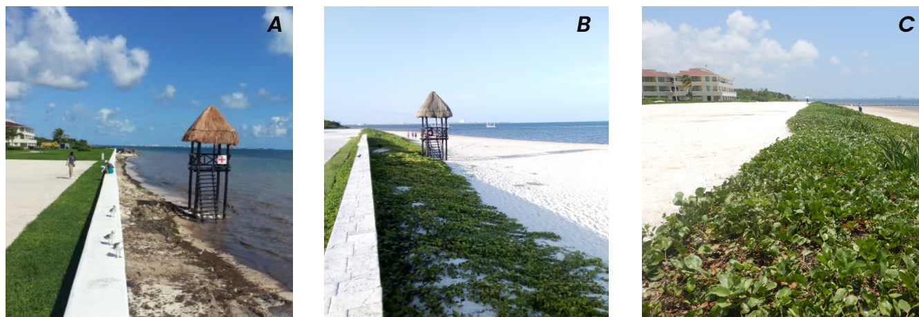
Figura 28. Playa norte del Hotel Moon Palace antes y después del proceso de rehabilitación topográfica con un relleno de arena y revegetación: A) 2017, B) 2021, C) 2022. Fotografías: Antonio Ortiz Hernández (A y B) y Calina Zepeda Centeno (C).
