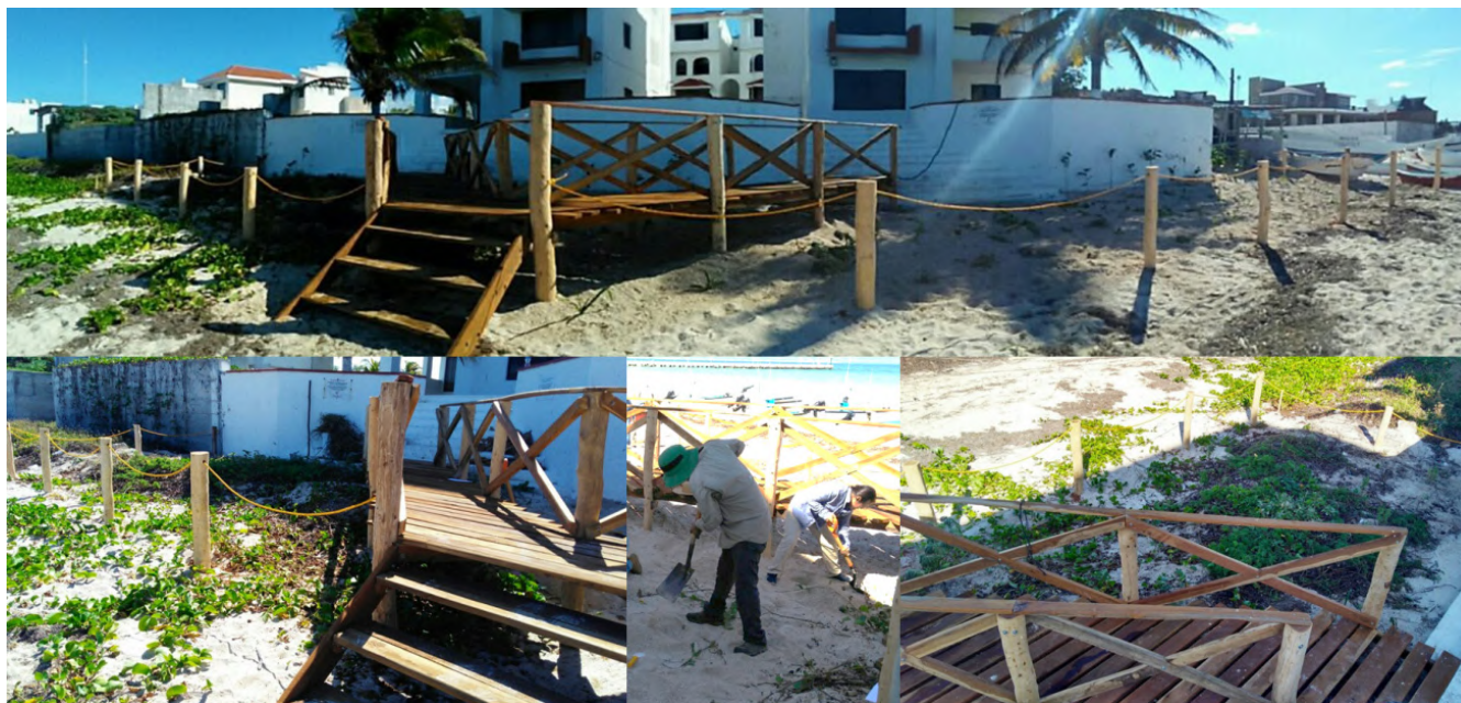
Figura 19. Pasarela en un proyecto de restauración en Telchac-Chixchulub. Se instaló una pasarela en forma de "V" en el frente de playa de los condominios Royal Beach 1, con una elevación aproximada de 50 cm. También se cercó el área revegetada con puntales de madera unidos por cuerda. Fotos: Gabriela Mendoza.
