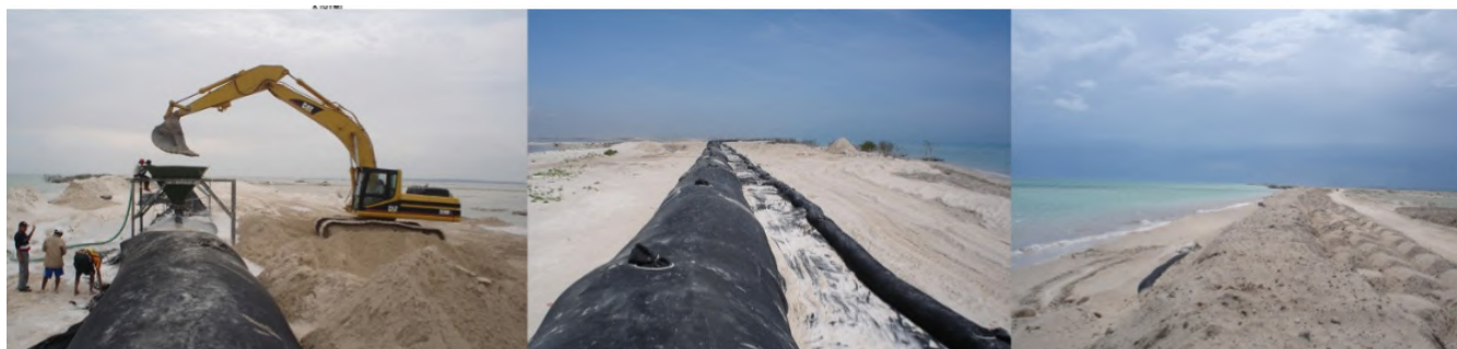
Figura 12. Construcción de una duna artificial con tubo geotextil en Las Coloradas, Yucatán.
